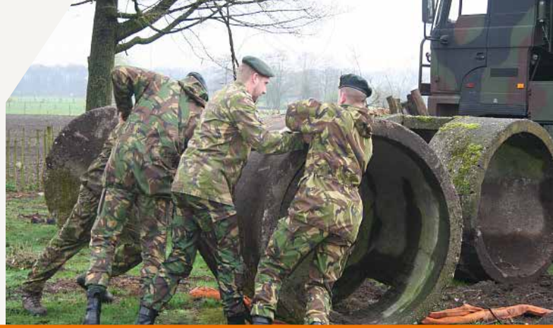
102 Constructiecompagnie van het 101 Geniebatljon oefende eind 2018 op het fort en herstelde daarbij loopgraven en kazematten.
