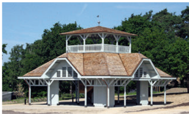
Gebouw 45 nagenoeg gereed
