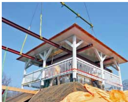
De uitkijkpost geplaatst op gebouw 45 (foto: Hans Baljet)
