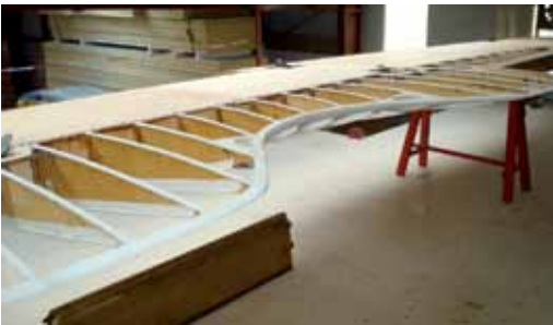
Bovenvleugel voorbereid voor bekleden
