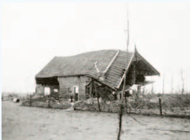
De boerderij van de familie Los nadat het water was gezakt. De overlevenden werden vanonder de ingezakte luifel opgetakeld. het witte teken waarmee onze aandacht werd getrokken is nog zichtbaar
