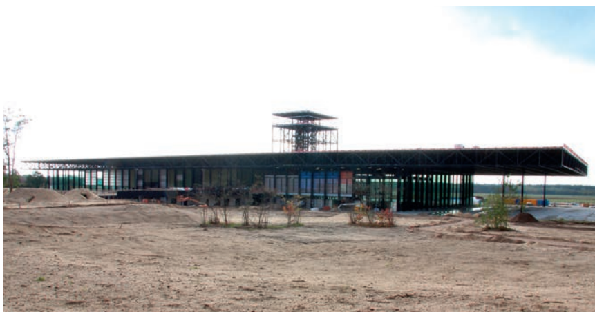
Overzicht van het museumgebouw, gezien aan de voorzijde. (Foto: Hans van Lith)
