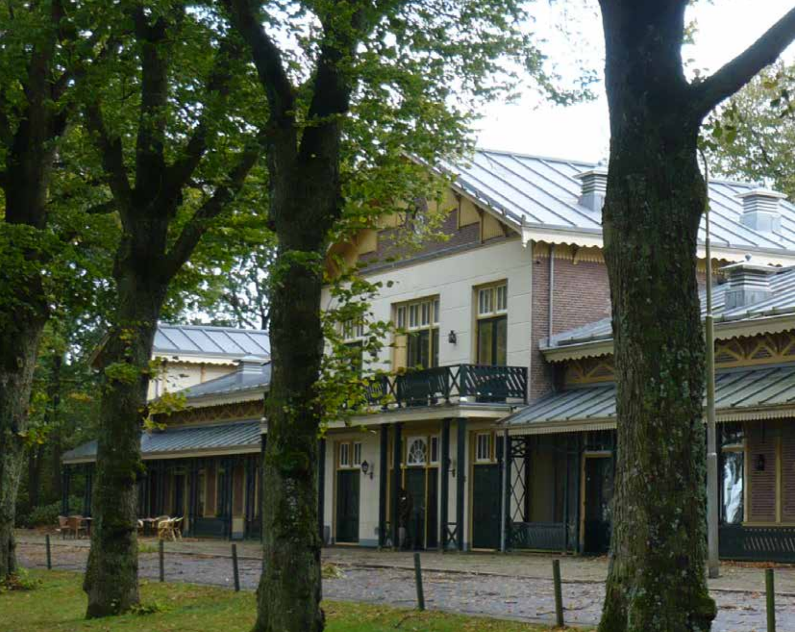
Gebouw 236: voormalig officierspaviljoen
