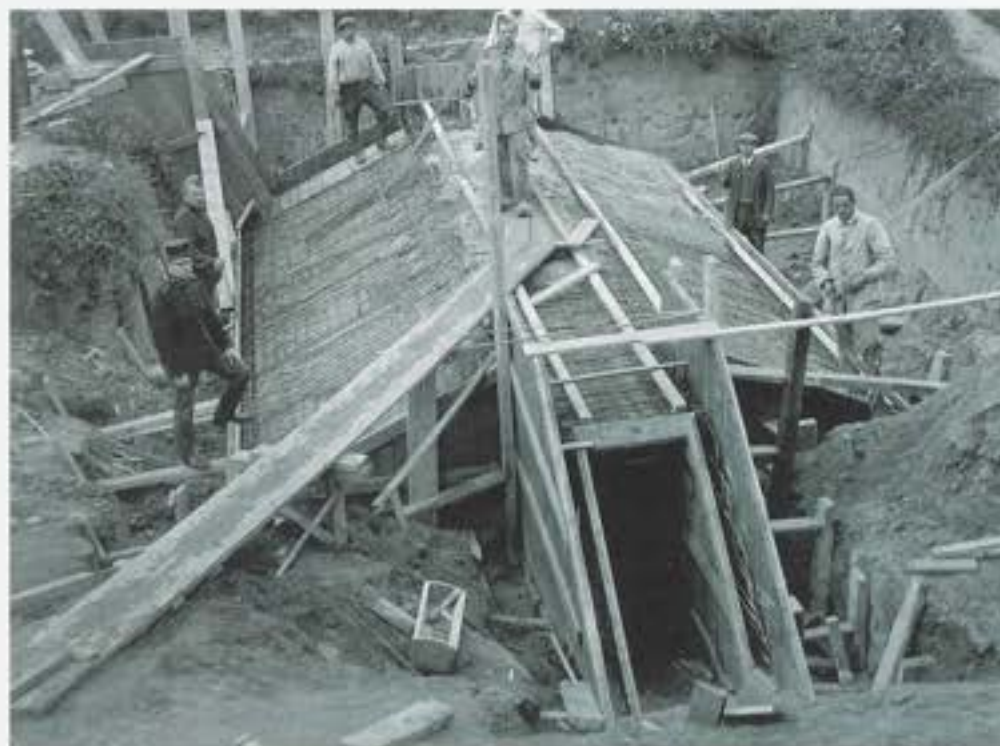
Afb. 11 De aanleg van een schuilplaats van gewapend beton in de wallen rond Willemstad. De bouw gebeurde door een lokale aannemer onder supervisie van een officier. De houten bekisting en de wapening zijn klaar, na het storten van het beton en een uithardingstijd van vier weken kon de schuilplaats in de wal opgenomen worden en aan het zicht onttrokken worden. (stichting Menno van Coehoorn)
