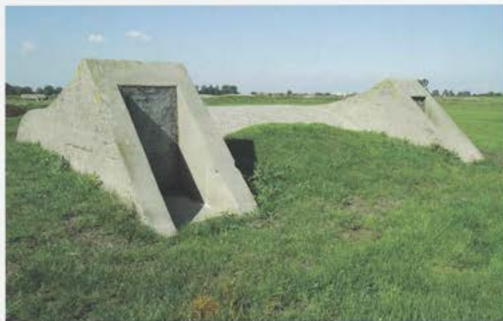
Afb. 7 Granaatvrije schuilplaats model 1916 (grote uitvoering met twee ingangen) bij Spaarndam. (foto Marius van Leeuwen)
