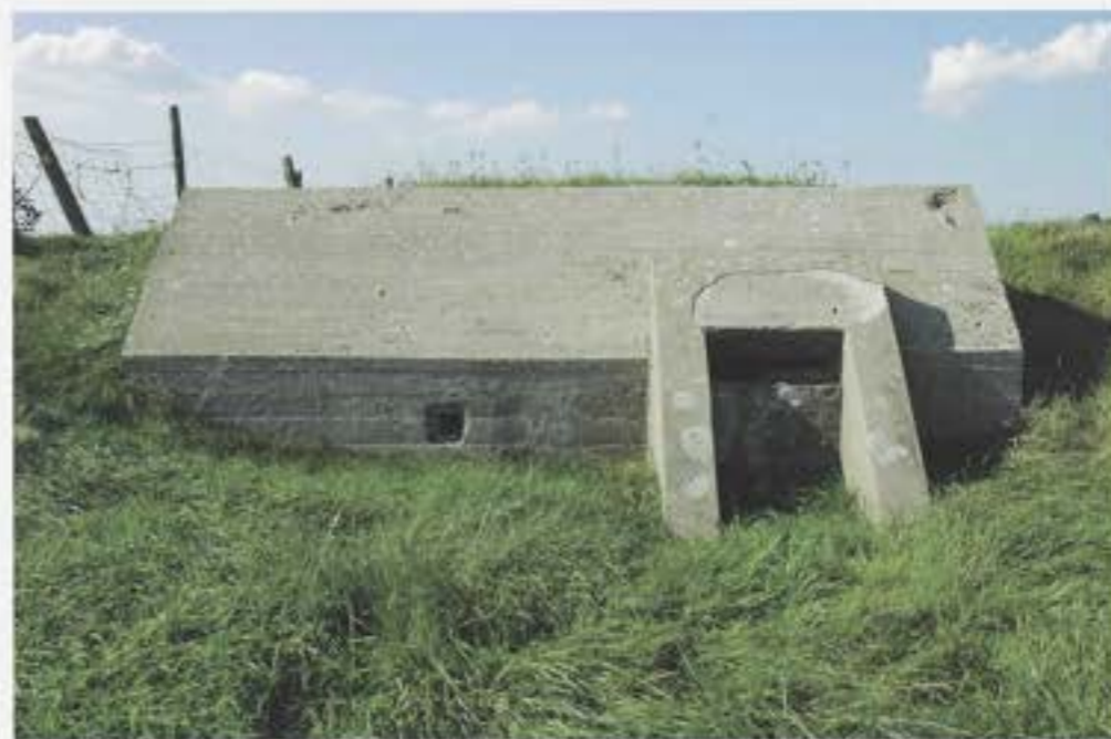
Afb. 8 Granaatvrije schuilplaats model 1918/1 (kleine uitvoering met één ingang) bij Spaarndam. (foto Marius van Leeuwen)
