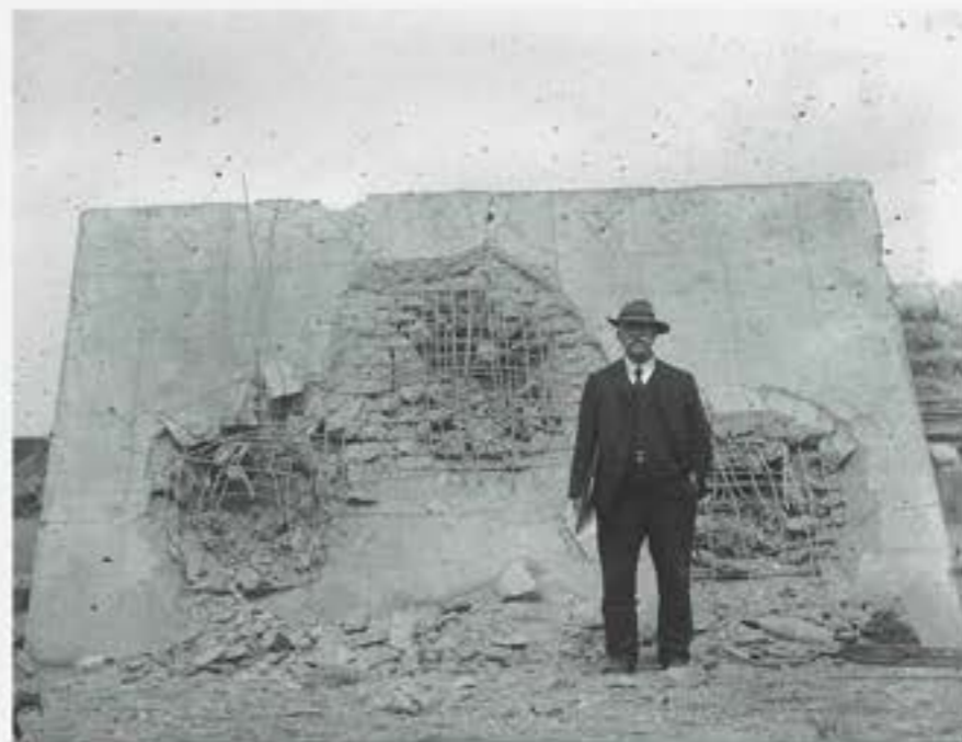
Afb. 4 Resultaat van een schietproef op een schuilplaats van gewapend beton, Oldebroek 1909. links op de voorgrond een pantsergranaat 15 cm. (inv. nr. 00114365)
