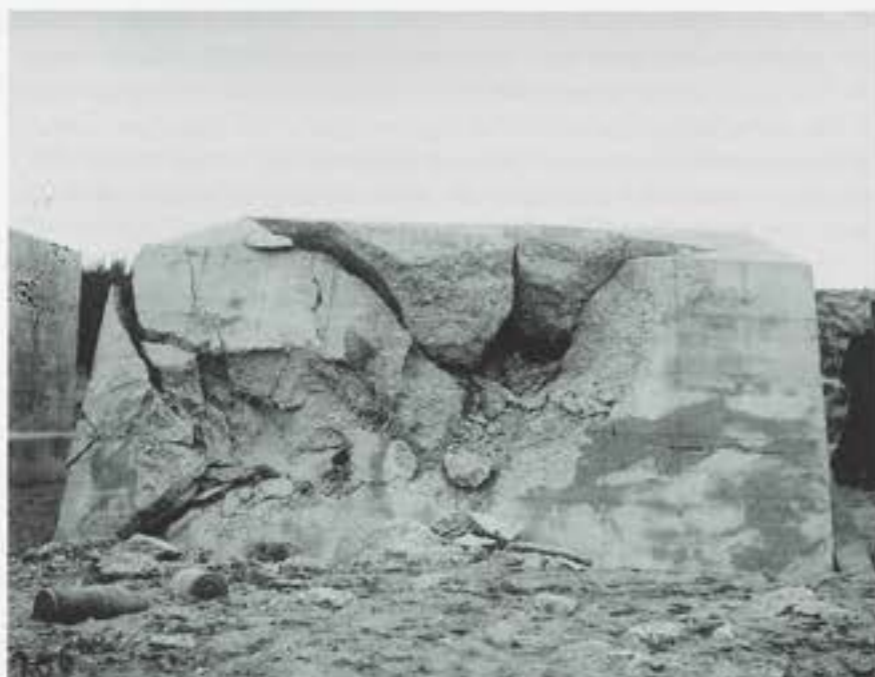
Afb. 3 Resultaat van een schietproef op een schuilplaats van ongewapend beton, Oldebroek 1909. Links op de voorgrond twee pantsergranaten 21 cm. (inv. nr. 00110210)
