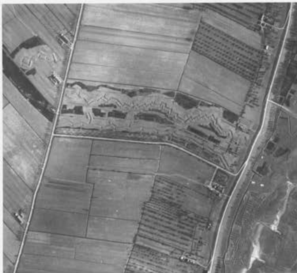
Afb.13 Luchtfoto van het Werk aan de Groeneweg, 1922. Het werk lag dwars op de Lekdijk en diende als vooruitgeschoven terreinverdediging van het fort Hanswijk dat er achter ligt (op de foto eronder, niet zichtbaar). In de dubbele loopgraafstelling lagen betonnen schuilplaatsen model 1918. Aan de andere zijde van de Lek lag voor fort Everdingen een soortgelijk verdedigingswerk, het Werk aan het Spoel. (stichting Menno van Coehoorn)
