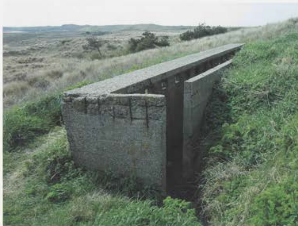
Afb. 10 Eén van de drie loopgraven van gewapend beton bij fort Kijkduin in de duinen bij Den Helder, aangelegd in 1916. (foto Marius van Leeuwen)
