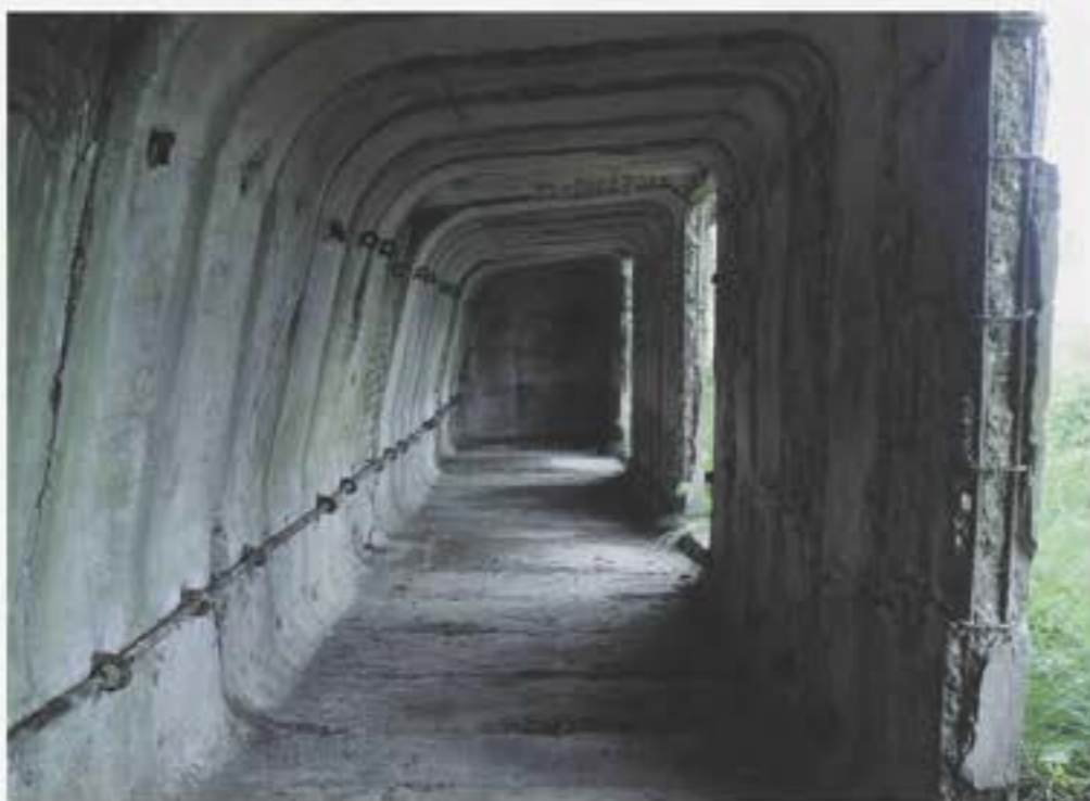
Afb. 5. Schuilplaats 1916. Goed te zien is hoe de ringsegmenten van gewapend beton bij elkaar worden gehouden door staalkabels. Deze schuilplaats ligt aan de gedekte gemeenschapsweg tussen fort Honswijk en het Werk aan de Korte Uitweg. De weg liep parallel aan een inundatiekanaal en maakte deel uit van de verdediging van het Lekaces van de Nieuwe Hollandse Waterlinie. (foto Marius van Leeuwen)
