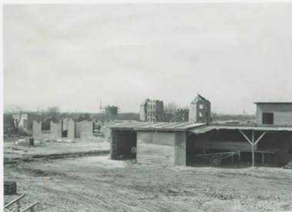
Abt. 2: Het zogenaamde puindorp of ruinedorp in aanbouw. Defensielocatie Craio (Laren), 1957. (Foto LFD)
