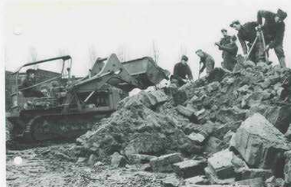
Abt. 4. Puinruimen. Mankracht met voorhamers en schoppen; afvoeren door een Fiat Angledozer; overhead-ladder de z.g. "puinhapper", 1958.
