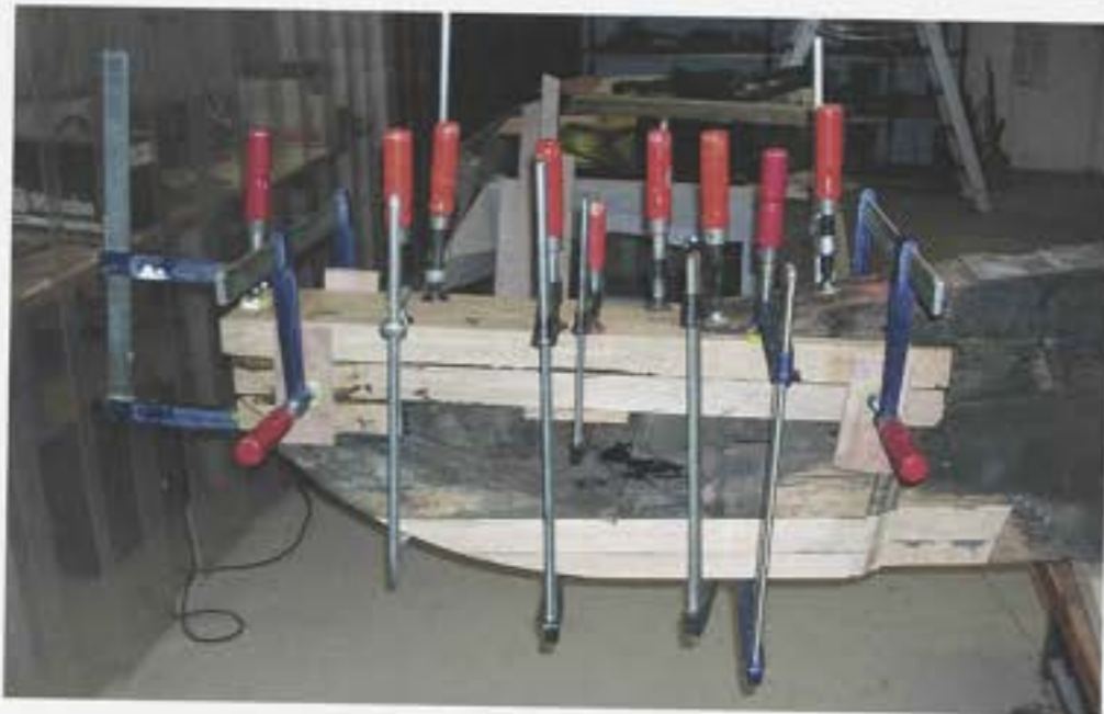
Afb.13 Vermolmd hout werd verwijderd en, met behulp van vele lijmklemmen, vervangen door nieuw eikenhout. (Foto B. Berkel)
