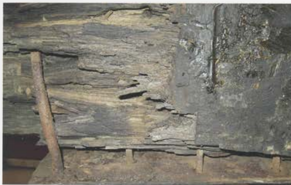
Afb. 12 Bij nadere beschouwing bleken aanzienlijke delen van het hout verrot te zijn door langdurige blootstelling aan weer en wind. (Foto B. Berkel)
