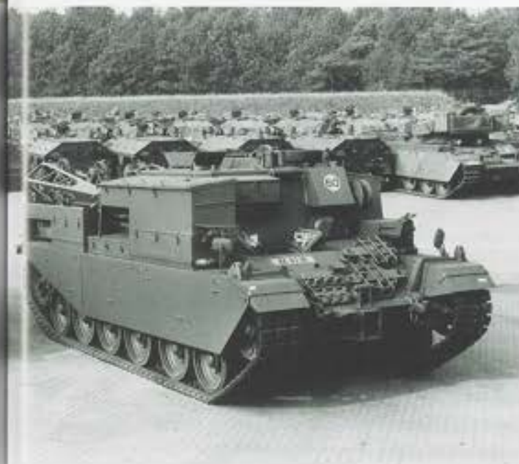
Afb. 4 (linker pagina) Door het ontbreken van de schortplaten is het loopwerk van deze Centurion Mk 5 goed te zien. De tank staat op het Cavalerie Schietkamp op Vlieland en is voorzien van een 'A-barrel'. (Foto waarschijnlijk LFFD, collectie W. den Dunnen)
