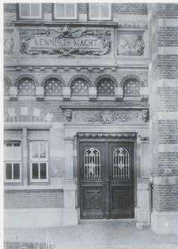
Abb. 13. Het Leergebouw met de Leraarsingang en de spreuk 'kennis is macht'. (Fa 076)
